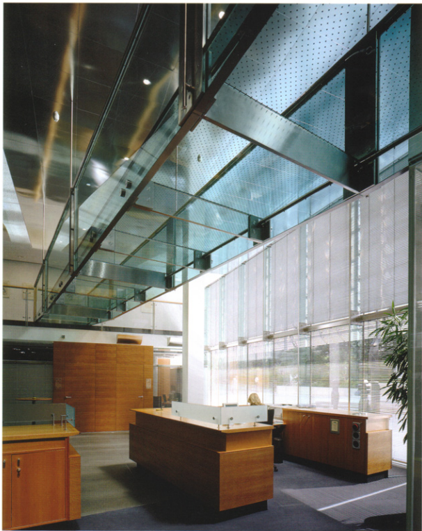
Raiffeisenbank Innsbruck, Glasbrücke: LITE-FLOOR R; Architekt: DI Heinz Örley; Foto: CROCE & WIR
