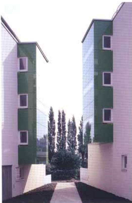
Wohnanlage Carminweg Architekt: Elsa Prochazka, Foto: Rupert Steiner
